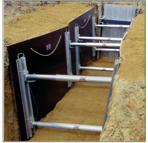
Sistema de apuntalamiento vertical hidráulico
