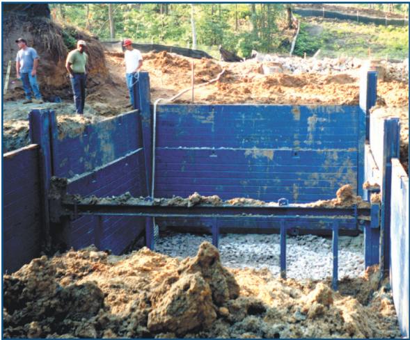
El sistema modular de rieles deslizantes GME/E+S en una aplicación lineal.
