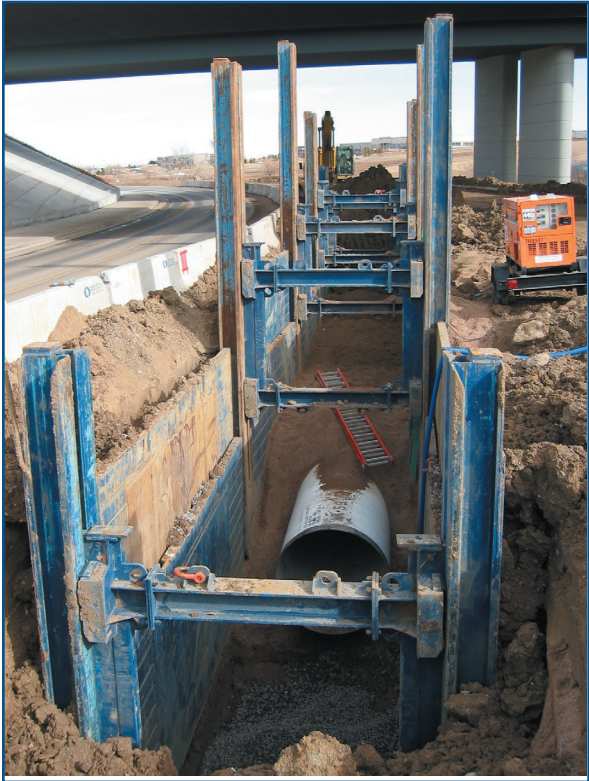
El sistema modular de rieles deslizantes GME/E+S en una aplicación lineal.
